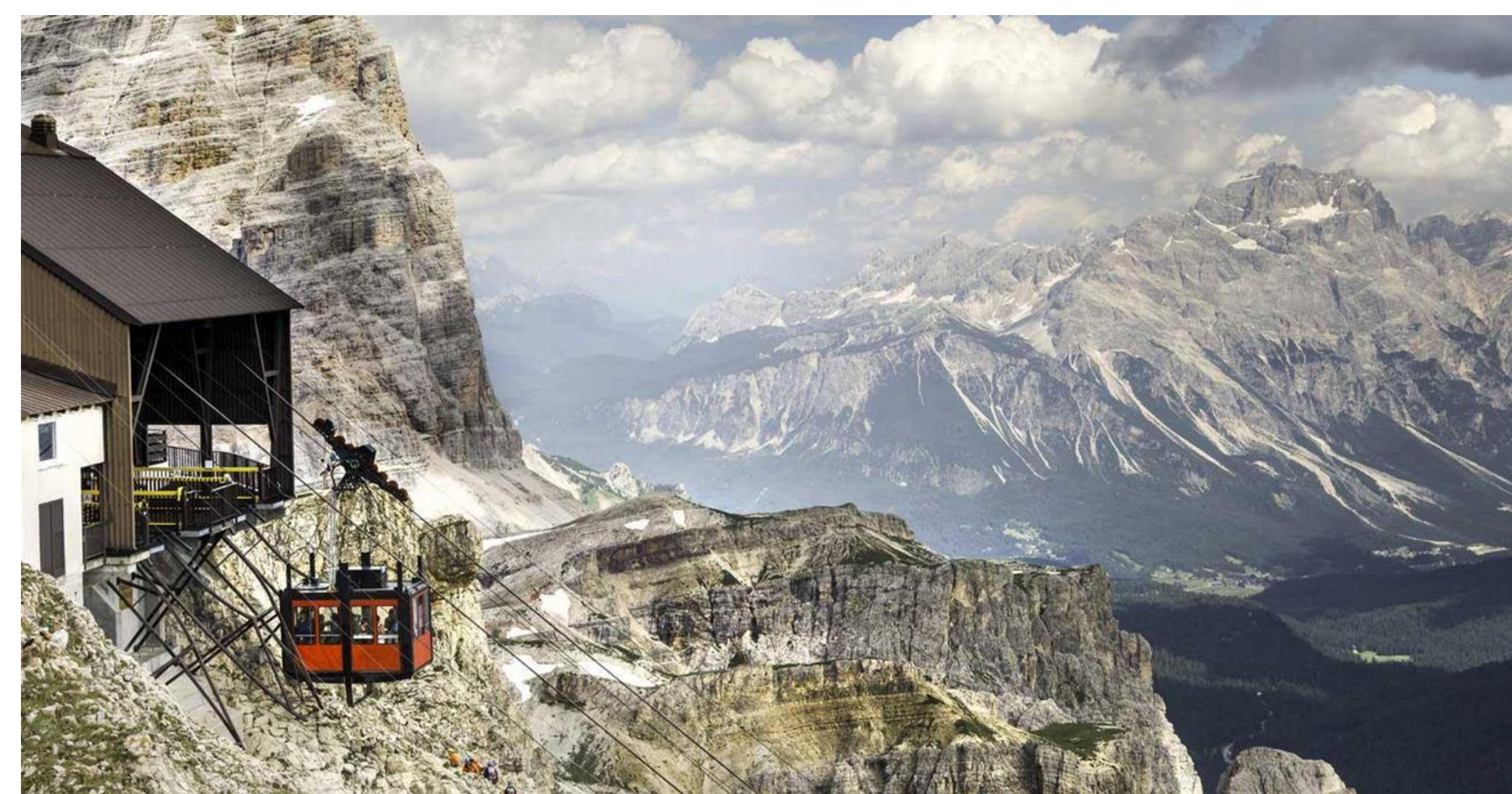
Fig. 3 The Lagazuoi plant Cortina d'Ampezzo (BL)
